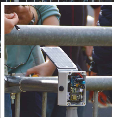
Der Pegelmesser wird installiert.
